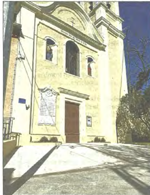
Les travaux de réfection de l'église St-Pierre-et-Paul de la Vernéa sont achevés. (Photo O. F.)
