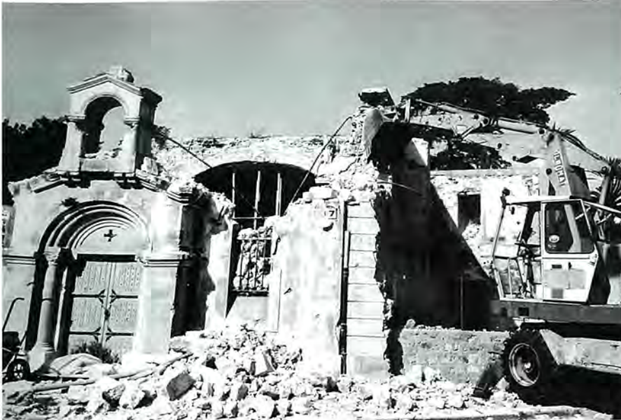
En 1968, les travaux de démolition commandés par les Ponts et Chaussées rasent le couvent, la villa et une partie de l'église. Des travaux de conservation sont réalisés sur la chapelle. Collection archives départementales des Alpes-Maritimes.
