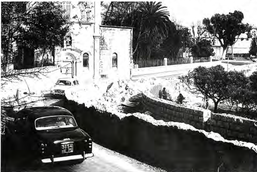
1955-1956. Reconstruction d'un mur de la propriété du palais de Carnolès dans le cadre de l'élargissement de la rue Paul-Morillot. À noter qu'à l'époque, le sens de circulation était inversé. © A.Chenier. Collection Ville de Menton.
