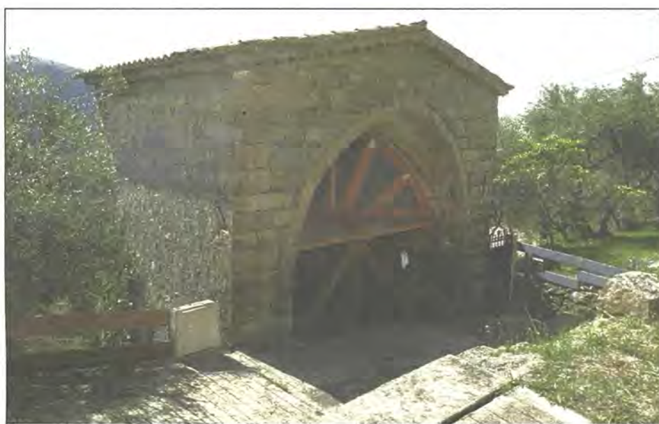
La restauration de la chapelle Saint-Jean-Baptiste a fait l'objet d'une convention entre la fondation du patrimoine et la mairie de Bonson. (Photo N. M.)
