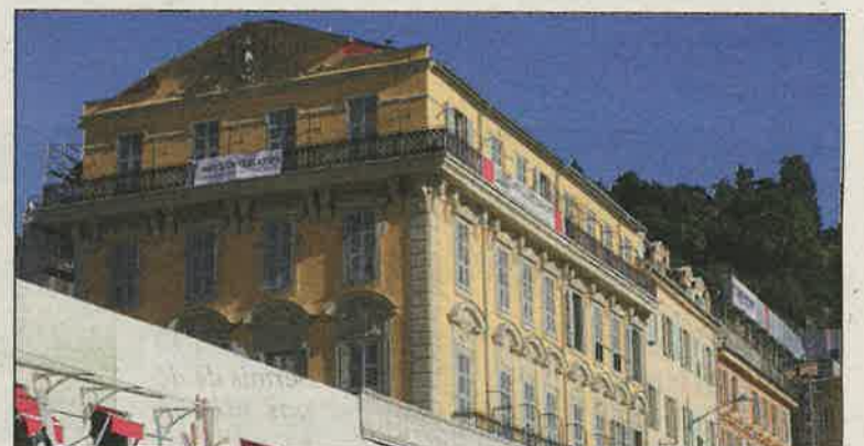
La façade sud (côté mer), elle aussi terminée avec rétablissement de l'alignement et de la disposition ancienne, notamment des fenêtres. (Photo Eric Ottino)
