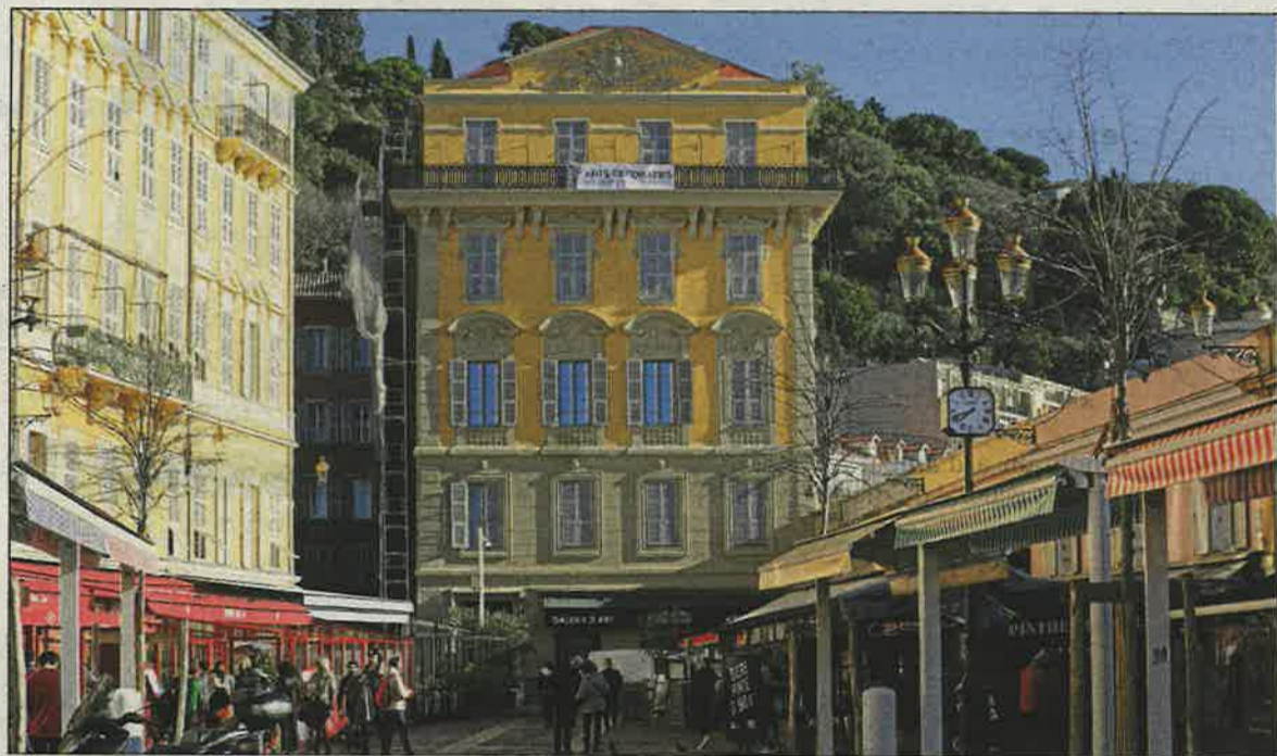
La façade ouest du palais Ribotti-Caïs-de-Pierlas : en bichromie ocre jaune et couleur pierre pour renouer avec les origines de la somptueuse bâtisse. (Photo Eric Ottino)
