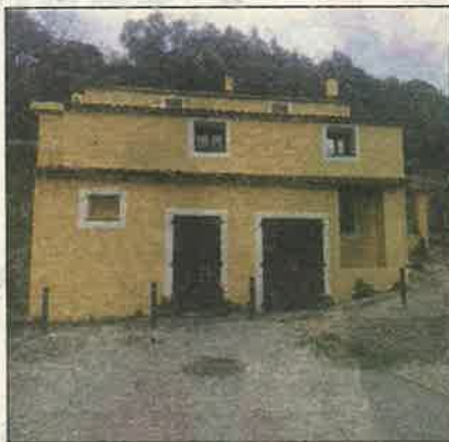
Le vieux moulin de la Laouza a bénéficié de travaux de restauration. (Photo O. F.)
