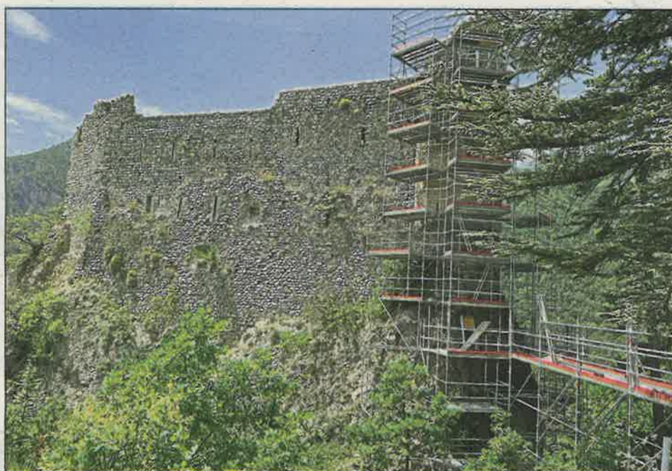
Des échafaudages tout neufs grimpent depuis quelques jours, à l'assaut de la tour, qui doit être réhabilitée. (Photos Ch.R.)
