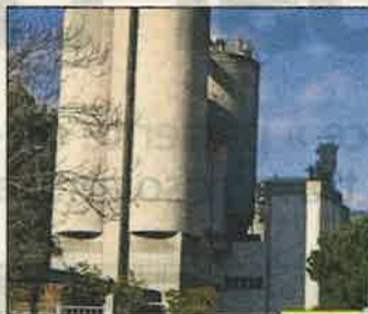
L'usine d'exploitation de ciment, aujourd'hui à l'arrêt.
