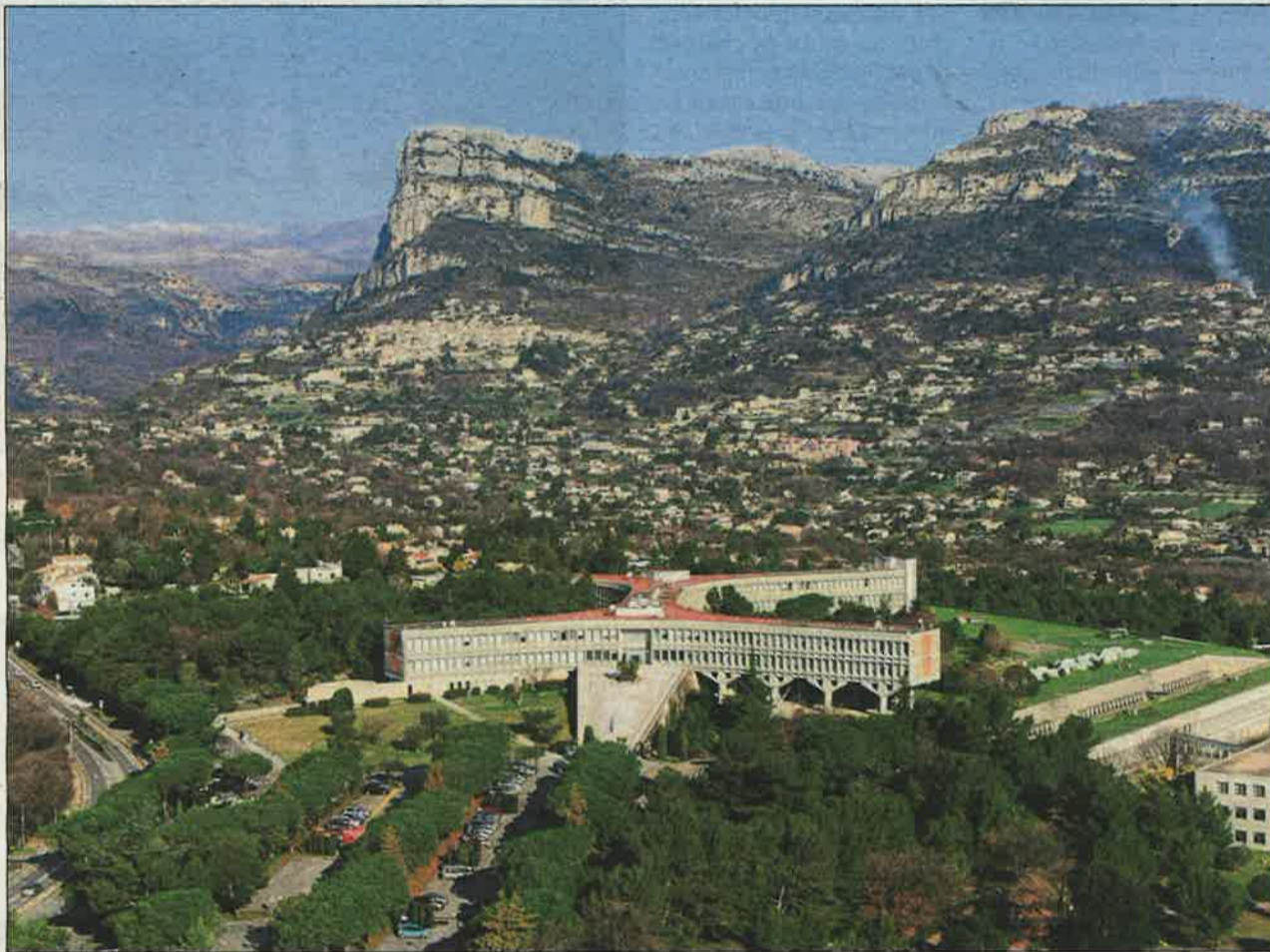
Le site d'IBM, à La Gaude, en août 2015. Date à laquelle l'entreprise américaine d'informatique déménage à Nice Méridia. (Photo Franck Fernandes)
