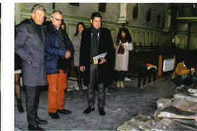
Le 19 décembre dernier, le Maire David Lisnard a effectué une visite de contrôle du chantier de restauration du maître-autel.
