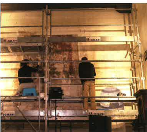
Chantier dans le chantier, la restauration de l'œuvre a débuté en septembre 2022 pour s'achever en ce début d'année.
