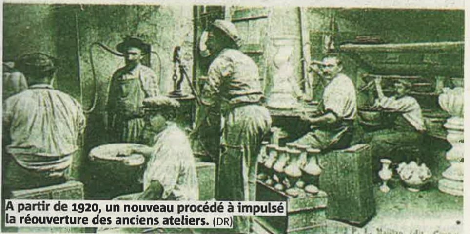
Les jarres étaient d'abord séchées à l'ombre, puis au soleil avant d'être enfournées et cuites entre 800 et même 880 degrés. (DR)
