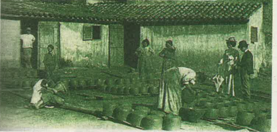
Les jarres étaient d'abord séchées à l'ombre, puis au soleil avant d'être enfournées et cuites entre 800 et même 880 degrés. (DR)
