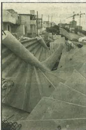
2 Photo : Jean Dieuzaide, Chantier avec des escaliers préfabriqués en béton.
