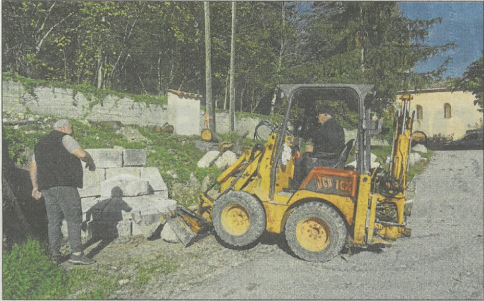
Le maire, au volant de sa mini pelle, participe à la construction. (Photo C. B.)
