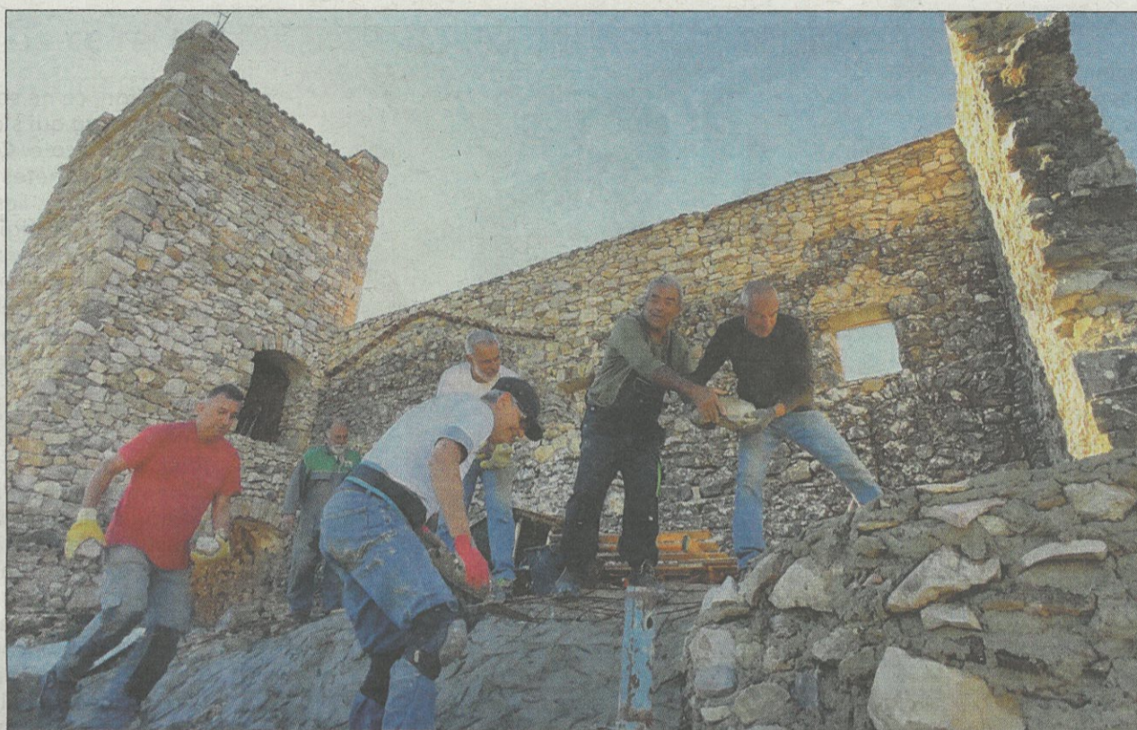
Chantier de Castel Nuovo à Châteauneuf-Villevieille le samedi 5 octobre 2024.
