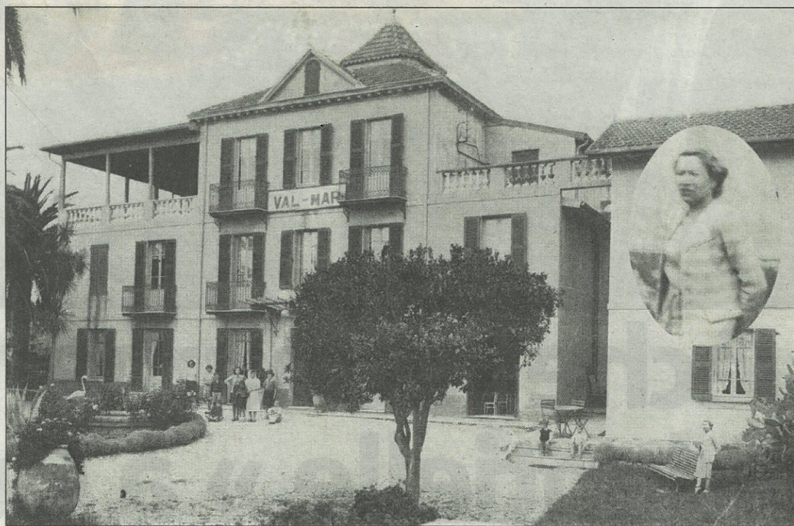
Fondé par Gaby Morel (en médaillon) en 1942, le Castel Val-Mar, établissement à caractère sanitaire, a accueilli des enfants venus se refaire une santé dans un cadre enchanteur.
