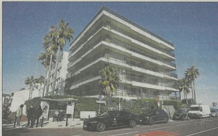
Au Palm Beach, un immeuble entier, inoccupé depuis des dizaines d'années, se délabre au fil des ans.
