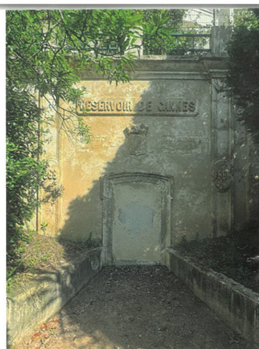
Construit en 1868 pour alimenter la commune en eau potable, l'ancien réservoir du square Méro avait perdu toute affectation au fil du temps.
